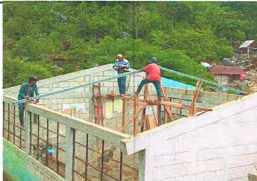
Foto 2: Colocación de estructura de techo
