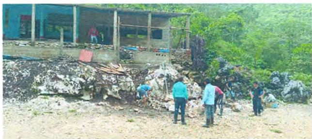
Foto 5: Colocación de muro de contención
