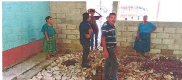
Foto 6: Colocación de piedras de nivelación del interior del nuevo edificio escolar
