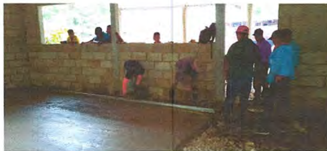
Foto 4: Colocación de piso
