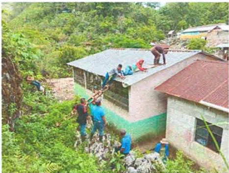
Foto1: Sustitución de cubierto de laminas
