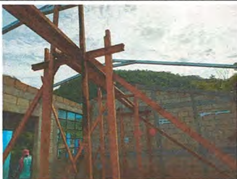
Foto 3: Sustitución de estructura de techo
